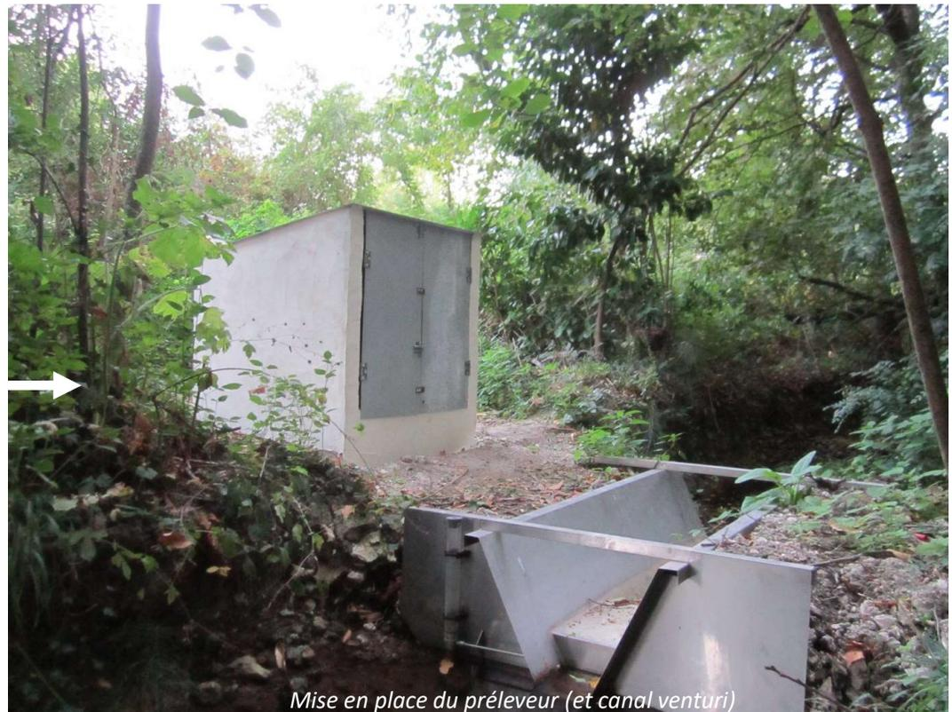
*Mise en place du préleveur (et canal venturi)*
